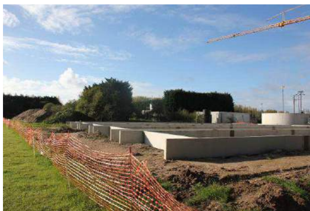
Aménagement de la nouvelle station d'épuration en 2012
